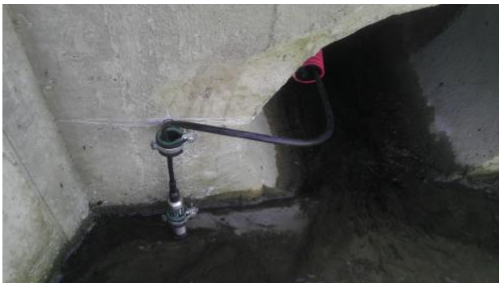
Tlakový hladinoměr u dna spodní výpusti poldru č.4
