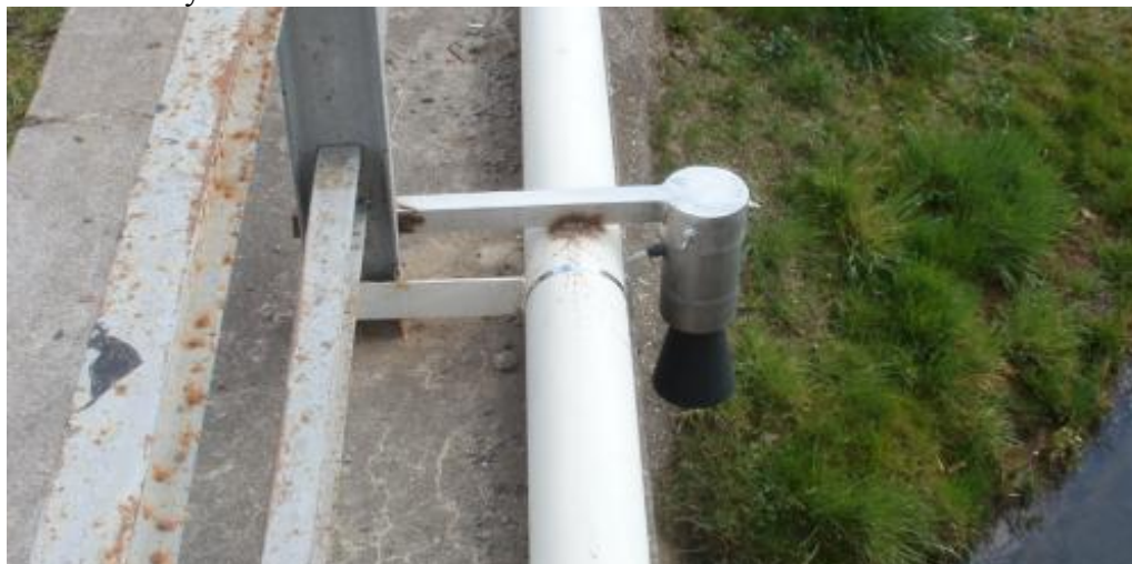
Ultrazvukový hladinoměr na mostovce
